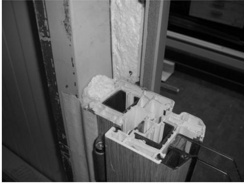
Thermische Trennung aufgrund dessen, dass das Fenster bei der Montage an den freigelegten Schaumkörper des Panels angelegt wurde. Innen und Außenseitig klebt das Multifunktionsdichtband.
