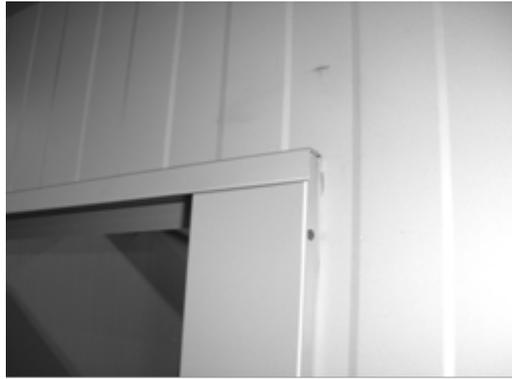
Die Sturzverkleidung ist nun fachgerecht eingebaut. Von den Kanten einwärts sollte die obere Kehlfuge beiderseits etwa 100mm lang mit Hybriddichtmasse abgedichtet werden. Keinesfalls darf die Dichtmasse über die Länge der Sturzverkleidung durchgezogen werden, das Wasser wäre ansonsten eingeschlossen!
