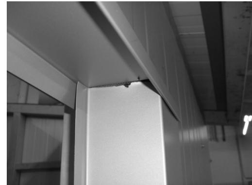
Das seitliche Leibungsblech wird hinterhalb der Tropfleistenabkantung montiert. Von unten wird eine Himmelverkleidung aus gekantetem Blech vorne eingehängt und rückwärts am Fenster befestigt.
