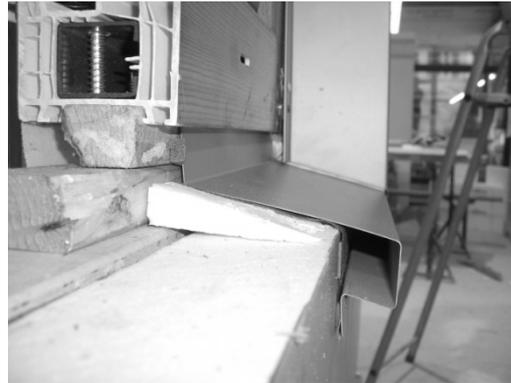
Der richtige Einbau der Sohlbank. Die Fenster müssen mit einem Sohlbankeinhängeprofil ausgestattet sein. Das Gefälle der Sohlbank nach außen beträgt mindestens 3° und der Überstand mindestens 25 mm. Die vertikale Sichtfläche darf nicht unter 20 mm ausgeführt sein.
