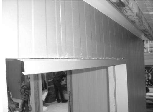
Der richtige Einsatz der Dichtbänder, verbunden mit handwerklicher Spenglerqualität der Verkleidungen gewährleistet die optimale Abdichtung. Tropfblech in das Panel eingebaut.
