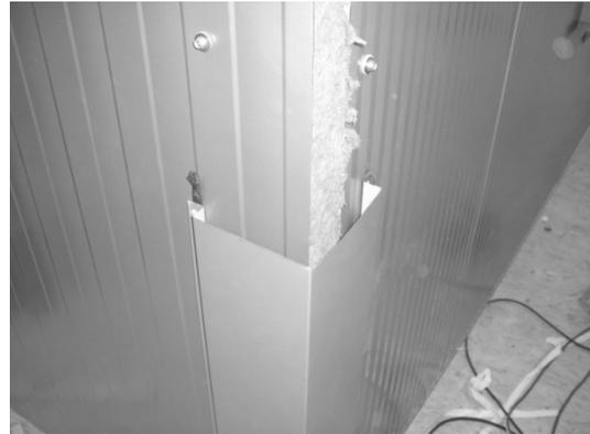
Hier die Industrie-, und somit preisgünstigere Variante, bei welcher die Befestigungslappen sichtbar sind. Auch hier sind wieder die Dichtbänder vom Typ D einzubauen.
