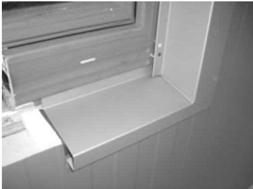
Das Fenster muss mit einem unteren Sohlbankanschlussprofil ausgestattet sein. Mit dem Dicht-band vom Typ H wird außenseitig dicht gemacht. Darüber kommt die Blechverkleidung.
