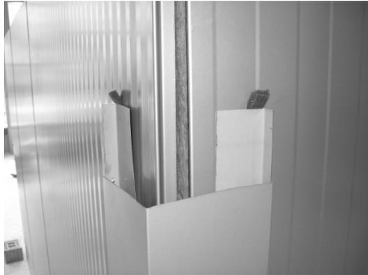
Die elegantere Art einer Eckverblendung mittels verdeckter Haftwinkel. Zwischen Paneeloberfläche und Haftwinkeln ist das Dichtband vom Typ D einzubauen. Die Haftwinkel können mit selbstbohrenden Schrauben befestigt werden. Das Eckblech selbst wird mit beschichteten Aluminierten mit Edelstahlhorn an den Flanken der Haftwinkel befestigt.
