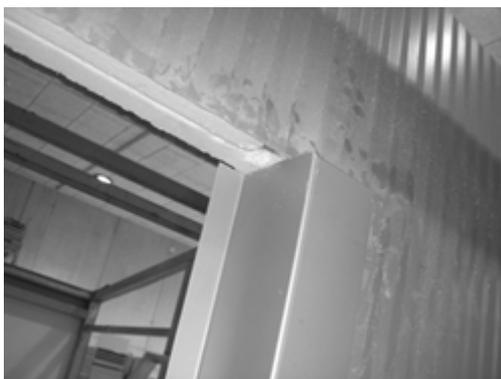
Im Sturz wird der Schaum hinter dem Außenfalz schlitzförmig ausgearbeitet, um später den Hochzug einbauen zu können. Beiderseits oberhalb der seitlichen Leibungsverblechungen ist eine Ausnehmung im Schaum herzustellen, damit die Hochkantung Platz findet.
